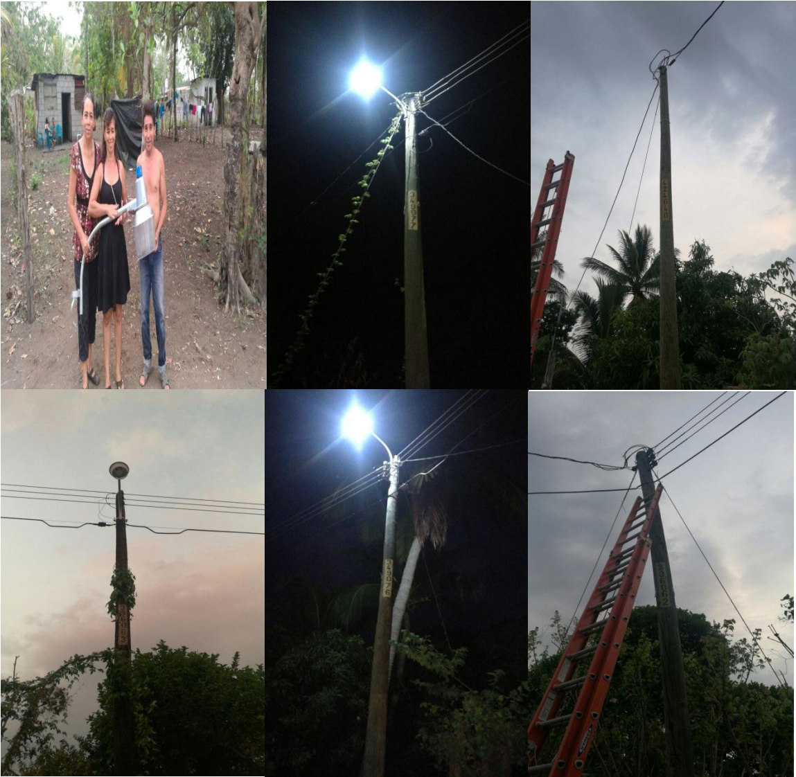
Miércoles 3 de mayo instalación de lámparas públicas en Caserío Las Brisas.
