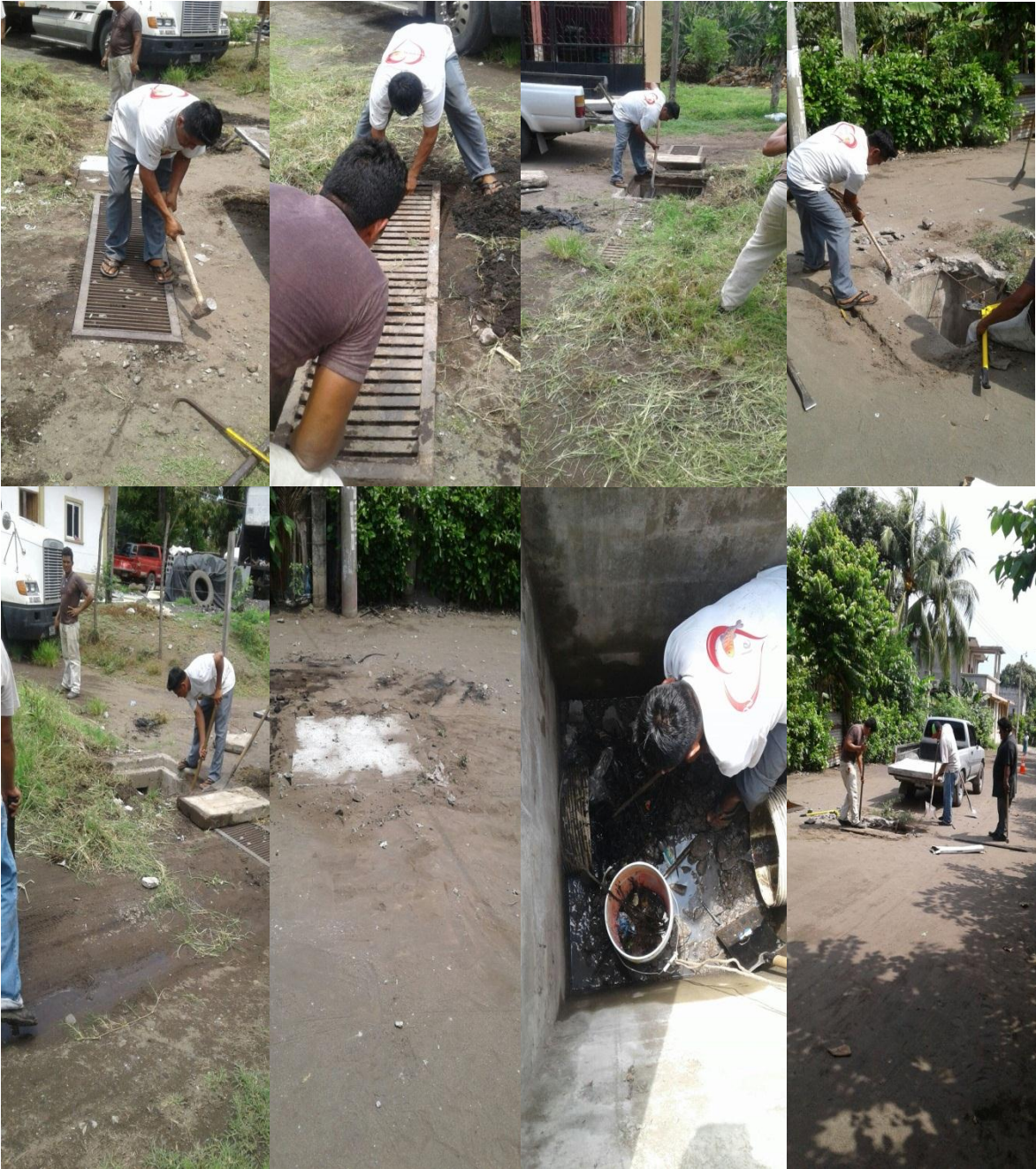
Se continuó con la limpieza y puesta de planchas de concreto de la colonia Guadalupe.
