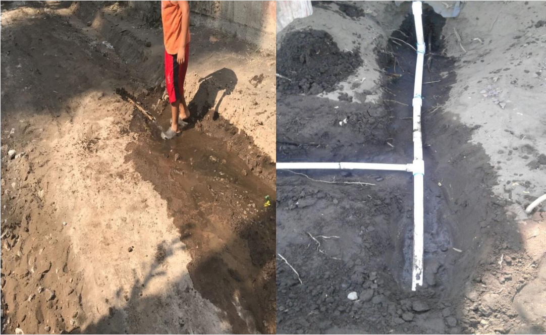
Reparación de tubería dañada por el patrol calle detrás de los juanes.
