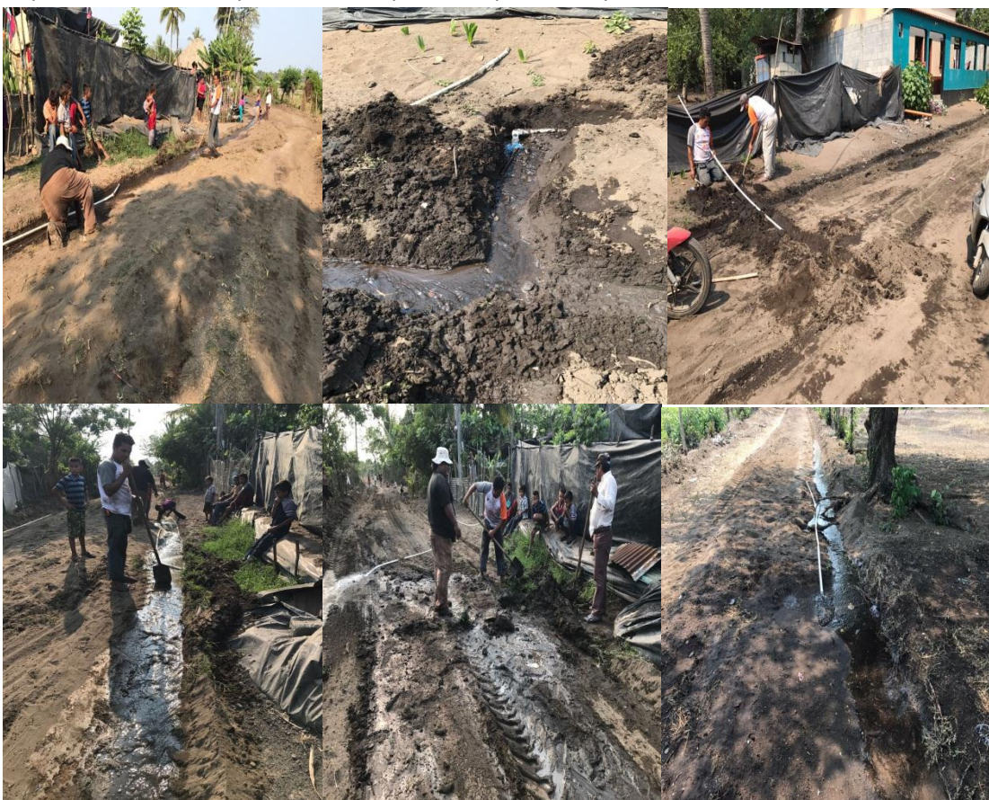
Reparación de tubos que se habían quebrado por la maquina muchos estaban sin contador.
