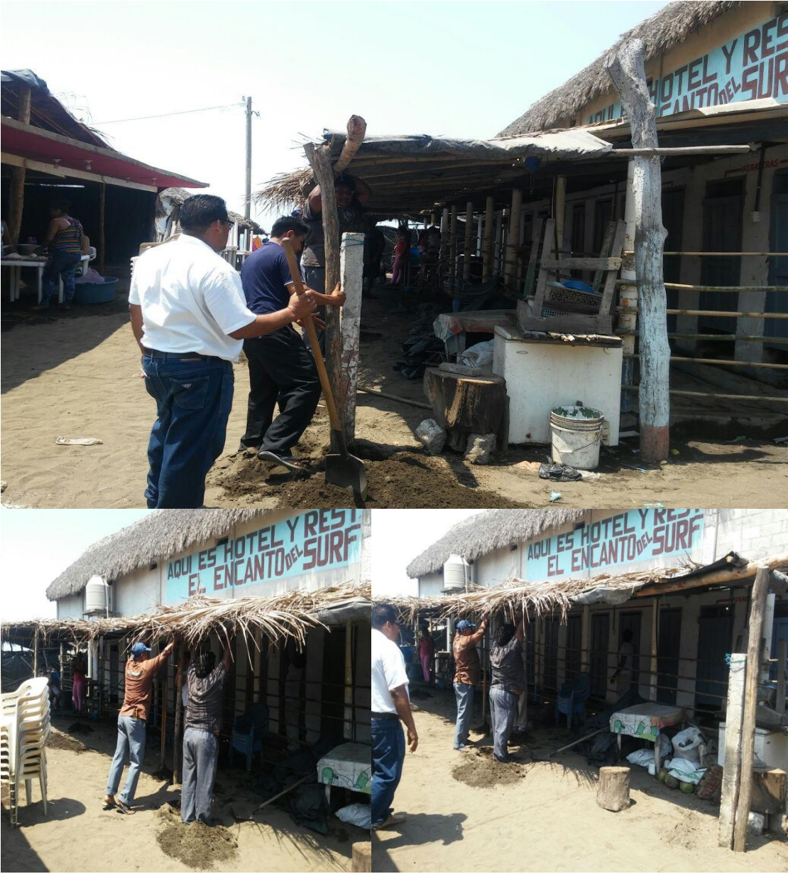
Personal Municipal a cargo del Sr Edgar Velazquez. Recorriendo en rramada para habilitar Paso de emergencia frente a los baños en la Empalizada.
