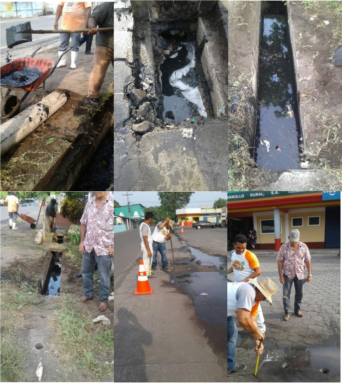
Martes 2 de mayo, Personal encargado de Drenajes, Empezaron con la limpieza de drenajes enfrente del Mercado Municipal.
