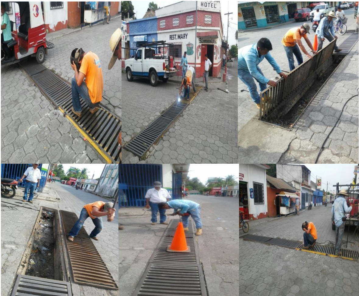
Viernes 05 de mayo, Reparación de rejillas en la dirección 5ta calle y 7ta avenida del Municipio.
