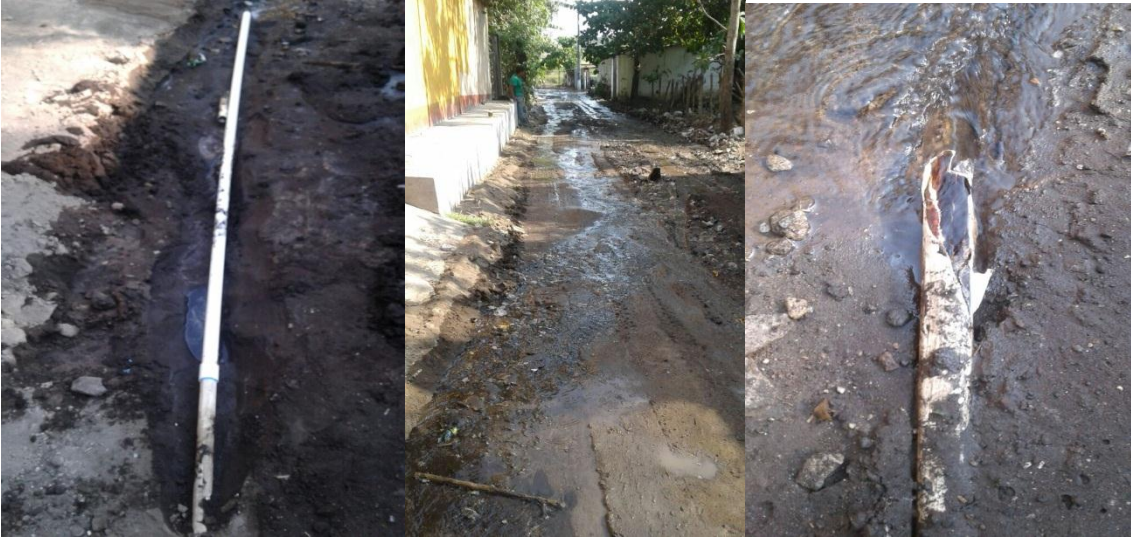
Reparación de tubería dañada por el patrol calle detrás de los juanes.
