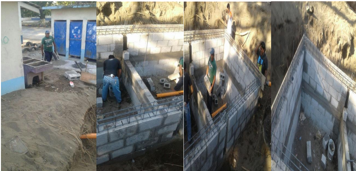
Continuación de la construcción de la fosa séptica de la Escuelona.
