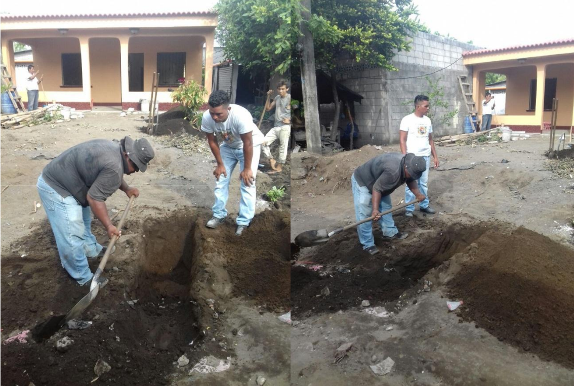
Instalación de servicio nuevo de agua en 4a avenida 2-15 colonia milagro de Dios. Sipacate.
