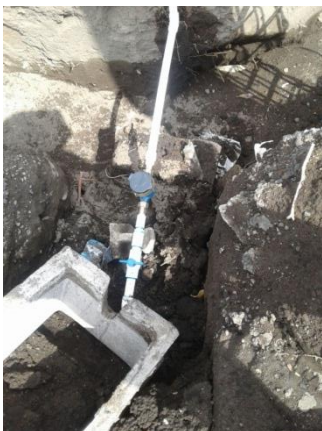
Contador Instalado de Agua potable en 6a calle 1-20
