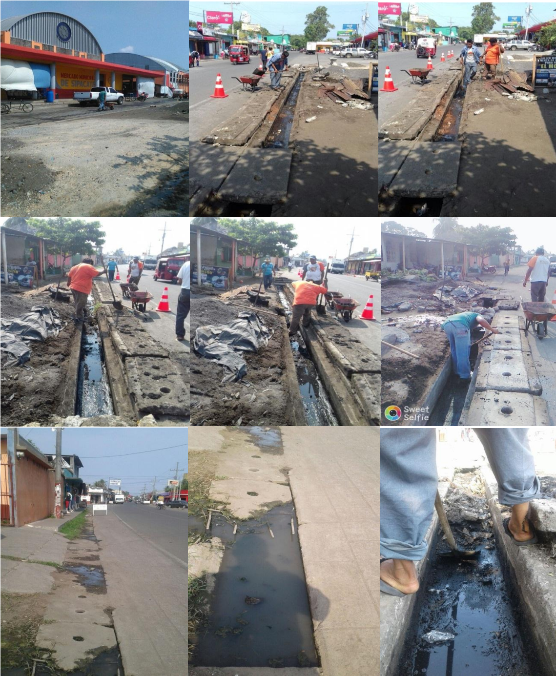
Miércoles 3 de mayo, limpieza de drenajes en el Casco Urbano de Sipacate.
