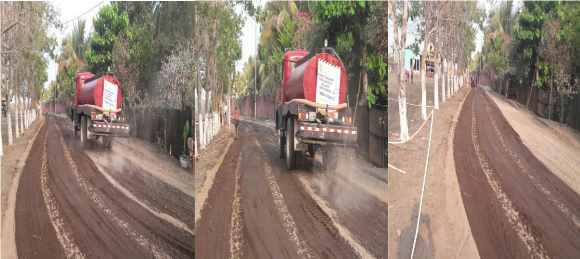
Mantenimiento de la calle principal del Caserío La Laguna Rama Blanca.
