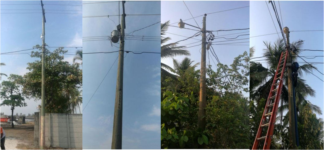
Instalación y reparación de lámparas públicas en carretera asfaltada hacia Rama Blanca
